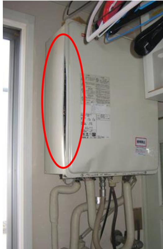
屋内設置の給湯器変形
