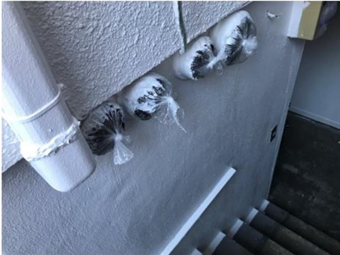
換気の排気口が養生で覆われた状態のため換気ができておらず、ガス機器の燃焼が不完全となり一酸化炭素が発生。中毒事故に至る可能性あり。
